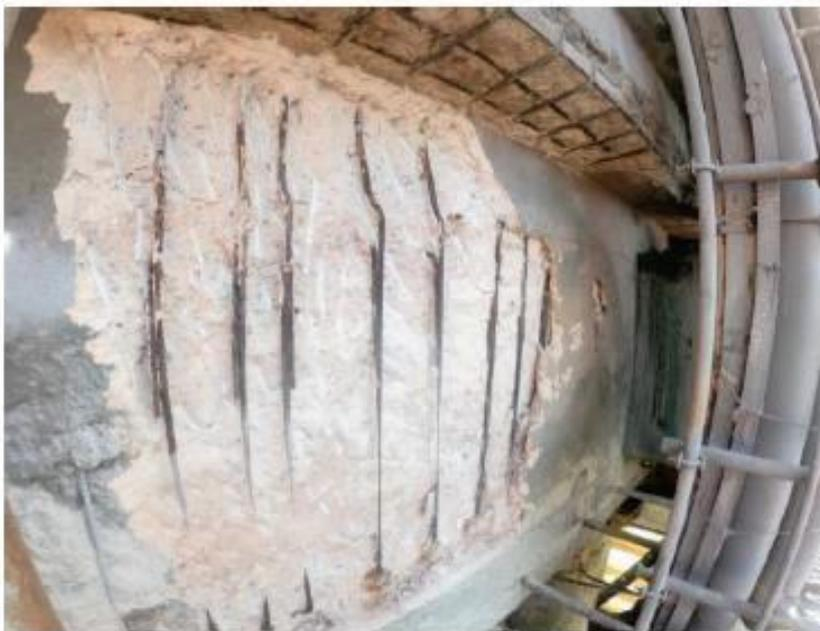
Figura 198 – Detalhe da demolição do concreto disgregado.
